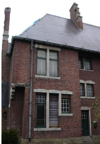
de linker zijgevel
