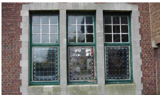
Ramen uit brandglas (bureel) achtergevel van het huis.
