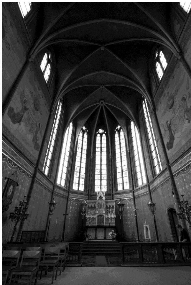
Kruisribben als stralenbundel uitwaaiend vanuit de tussenstijlen van de gotische ramen van het hoogkoor van de Sint- Gaugericuskerk in Pamel
